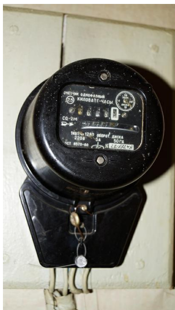
Рис.1. Индукционный однофазный электросчетчик.
